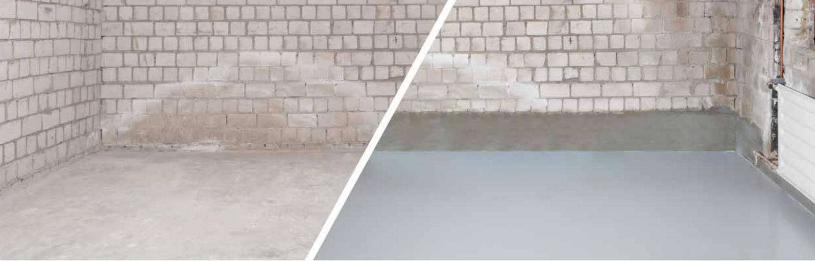
WP Flow ergänzt die Remmers Innenabdichtungssysteme in perfekter Weise. Ebenso wie die Systeme für den Wandbereich ist WP Flow gemäß WTA-Merkblatt 4-6, Nachträgliches Abdichten erdberührter Bauteile, mit 10 mm Schichtdicke gegen rückseitige Wasserbelastung geprüft und zugelassen. Im Übergangsbereich zwischen Wand und Boden lässt sich WP Flow perfekt an die bewährten Remmers-Systeme anarbeiten. Gleichzeitig lassen sich Unebenheiten in der Fläche ausgleichen.
